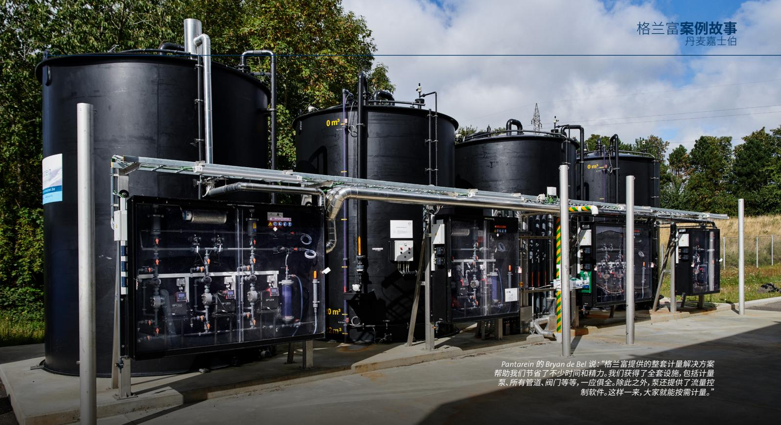
Pantarein 的 Bryan de Bel 说：“格兰富提供的整套计量解决方案帮助我们节省了不少时间和精力。我们获得了全套设施，包括计量泵、所有管道、阀门等等，一应俱全。除此之外，泵还提供了流量控制软件。这样一来，大家就能按需计量。”
