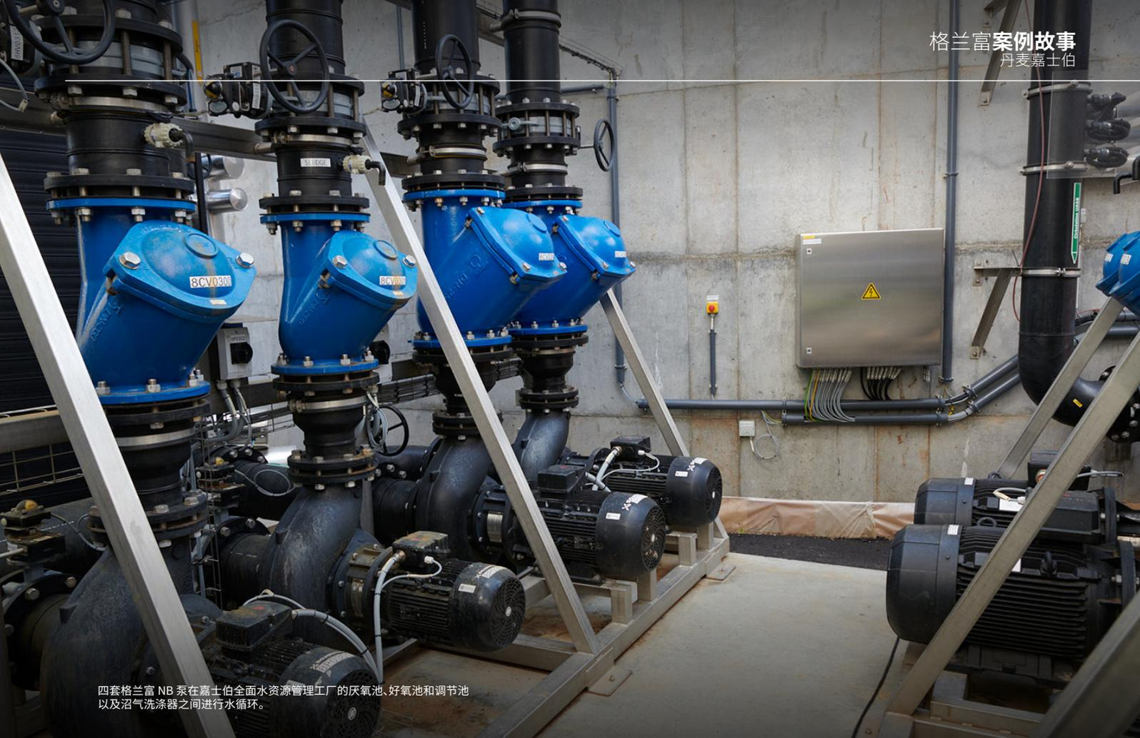
四套格兰富 NB 泵在嘉士伯全面水资源管理工厂的厌氧池、好氧池和调节池以及沼气洗涤器之间进行水循环。
