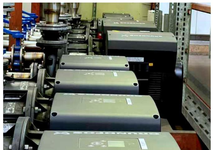
Une série de 14 pompes Grundfos NBE Dual équipées de moteurs à rendement premium IES de 11 kW qui fonctionnent avec une régulation de pression constante pour le refroidissement central de Lucozade.
