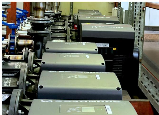
一系列 14 个格兰富 NBE 系统双泵，采用 11 千瓦高效 IES 电机，在恒压控制下运行，用于 Lucozade 中央冷却应用。
