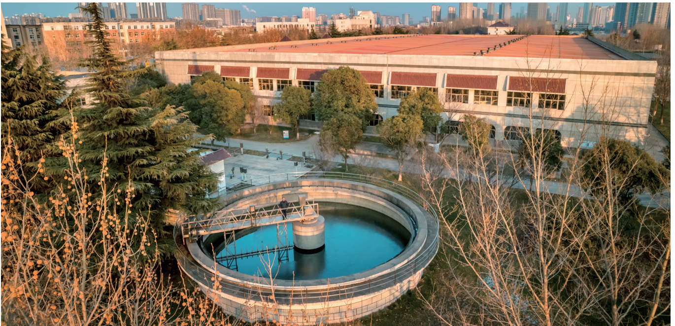
(铁西水厂的成功升级改造对于传统的供水行业起到了良好的示范作用)
