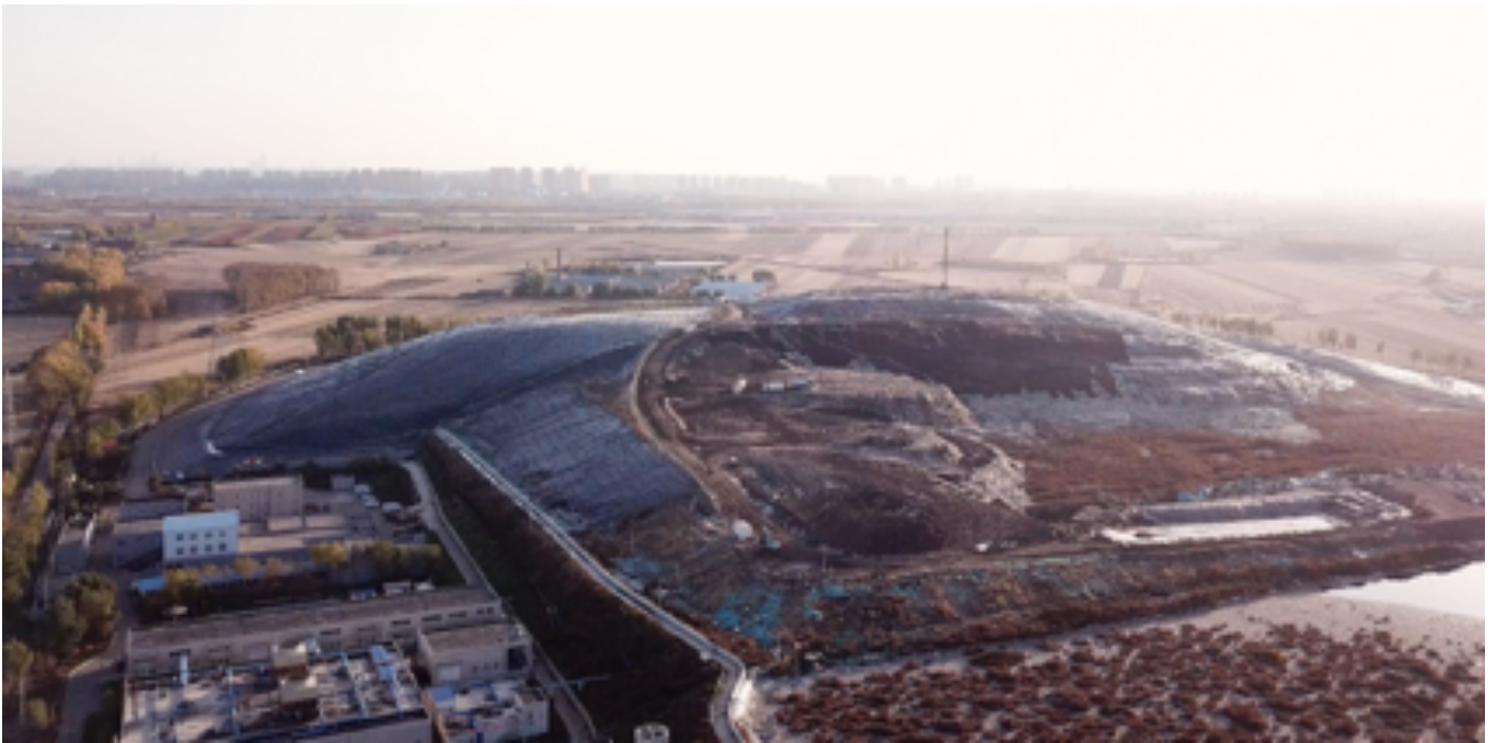
大辛垃圾填埋场, 远处背景是沈阳市区。
