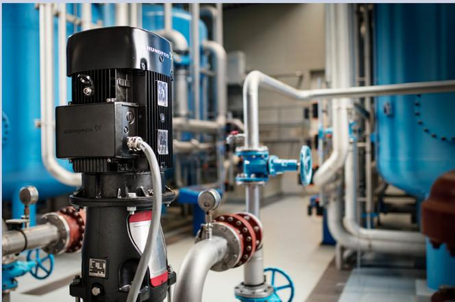
图片：奥地利上瓦特 WWSB 公司使用的格兰富 CR-95 多级泵。该泵比增压/过滤应用中的另一款不同品牌的老式泵要小得多。它能否担此重任？
