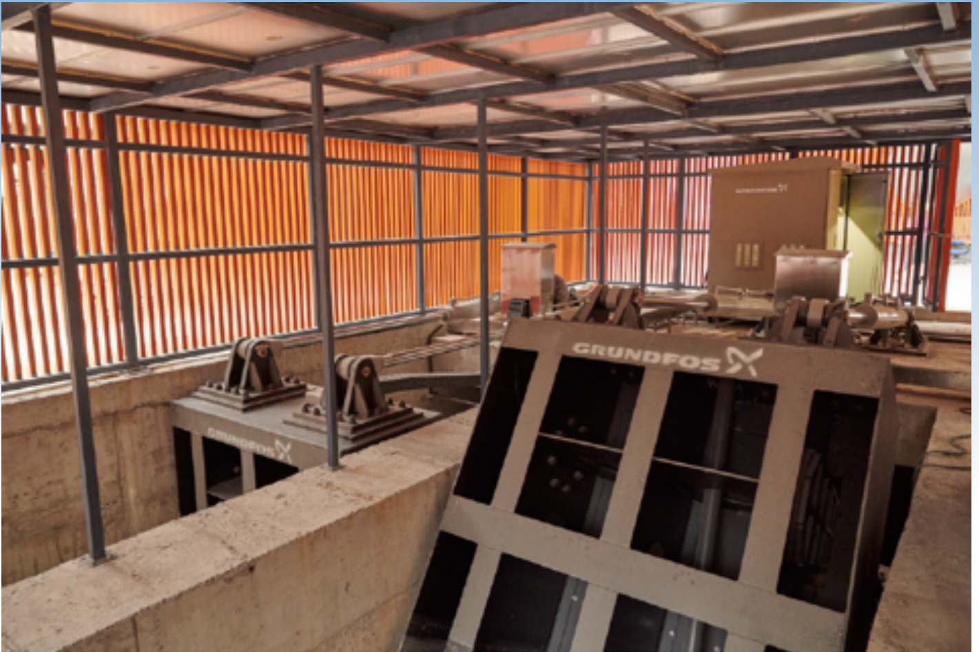
中国福州的格兰富泵闸
