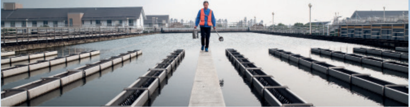
吴俊飞, 海盐县三地自来水厂运营负责人, 采取水样用于实验室测试
