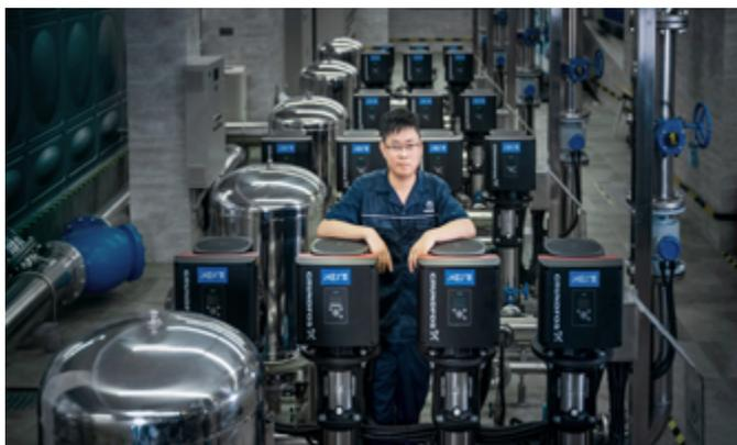
邱凌峰介绍说:“在二次泵房设计期间,我们采用了格兰富BIM(建筑信息建模 Building Information Modelling)的设计,合理布局泵房施工管段,从设计上就可以预见性的排除施工安装问题。”
