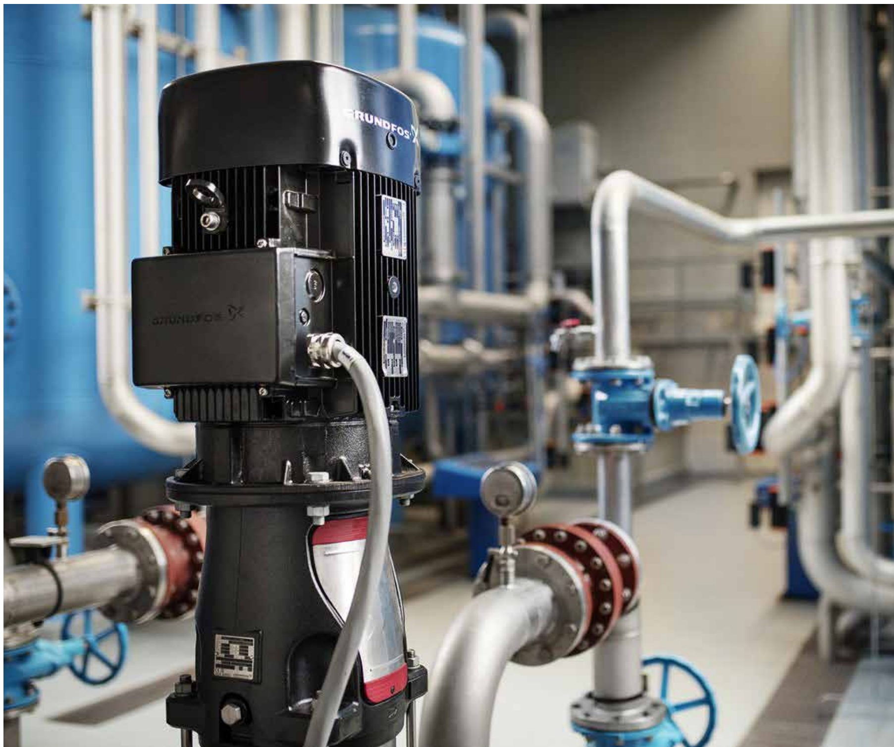
奥地利奥伯瓦特（Oberwart）WVSB 的格兰富 CR-95 多级泵
