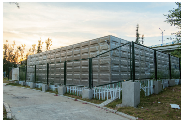
图为新建的格兰富后渚加压泵站
