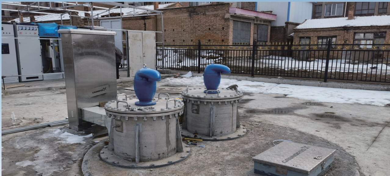
该雨水泵站已经落成,不仅完美融入周边环境,还可以起到跟传统大型雨水泵站一样的作用,有效解决当地夏季汛期内涝的问题。
